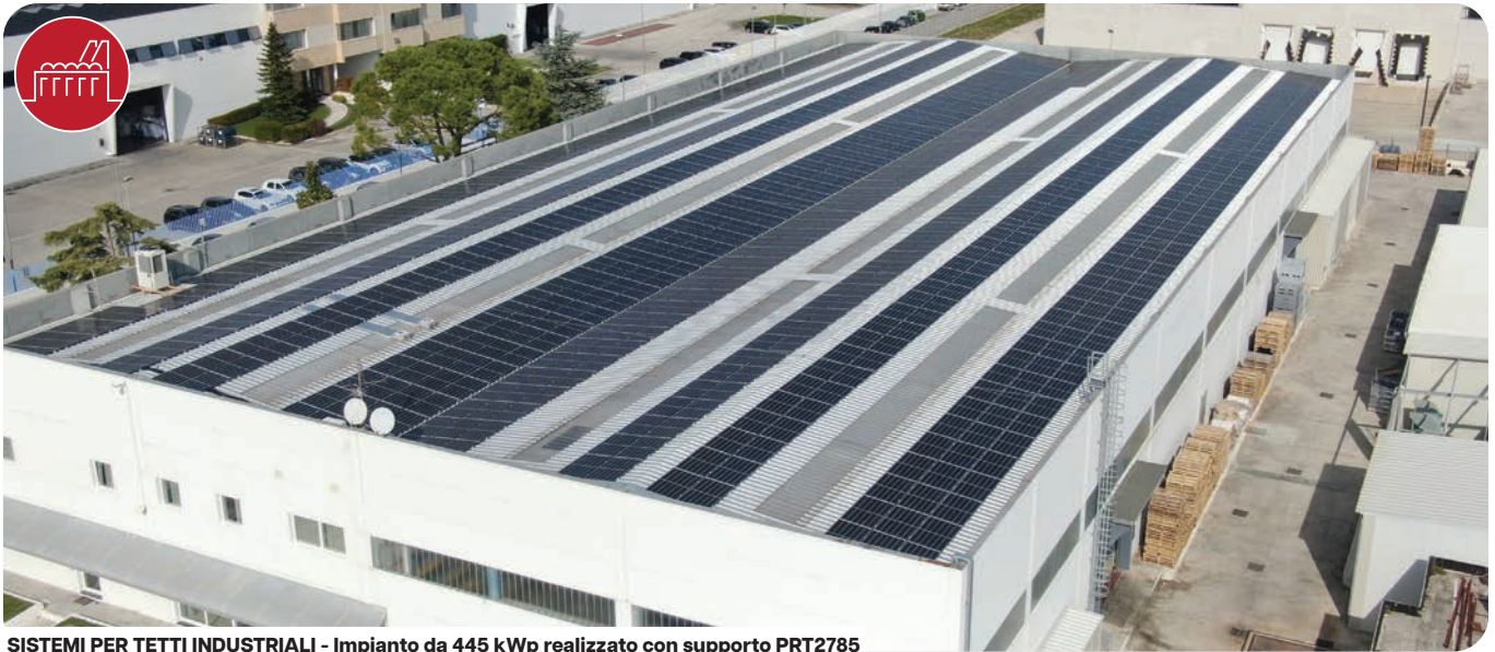
SISTEMI PER TETTI INDUSTRIALI - Impianto da 445 kWp realizzato con supporto PRT2785
