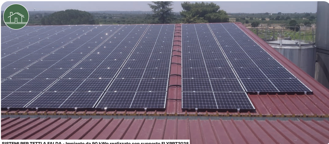
SISTEMI PER TETTI A FALDA - Impianto da 90 kWp realizzato con supporto FLYPRT2038
