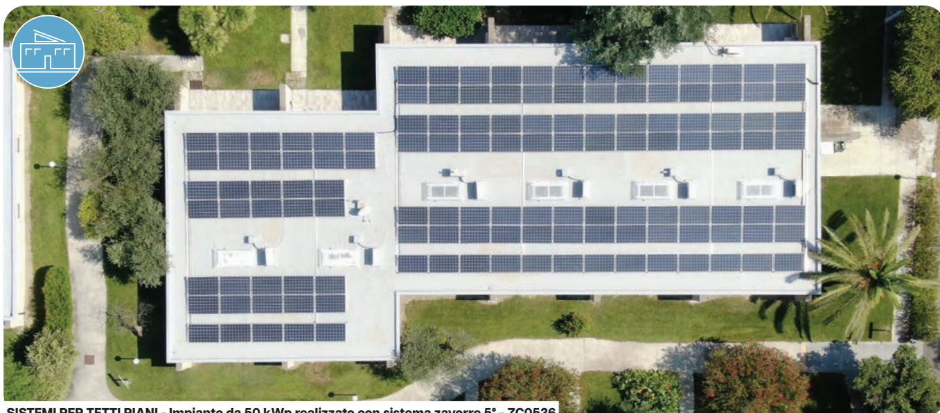
SISTEMI PER TETTI PIANI - Impianto da 50 kWp realizzato con sistema zavorre 5° - ZC0536
