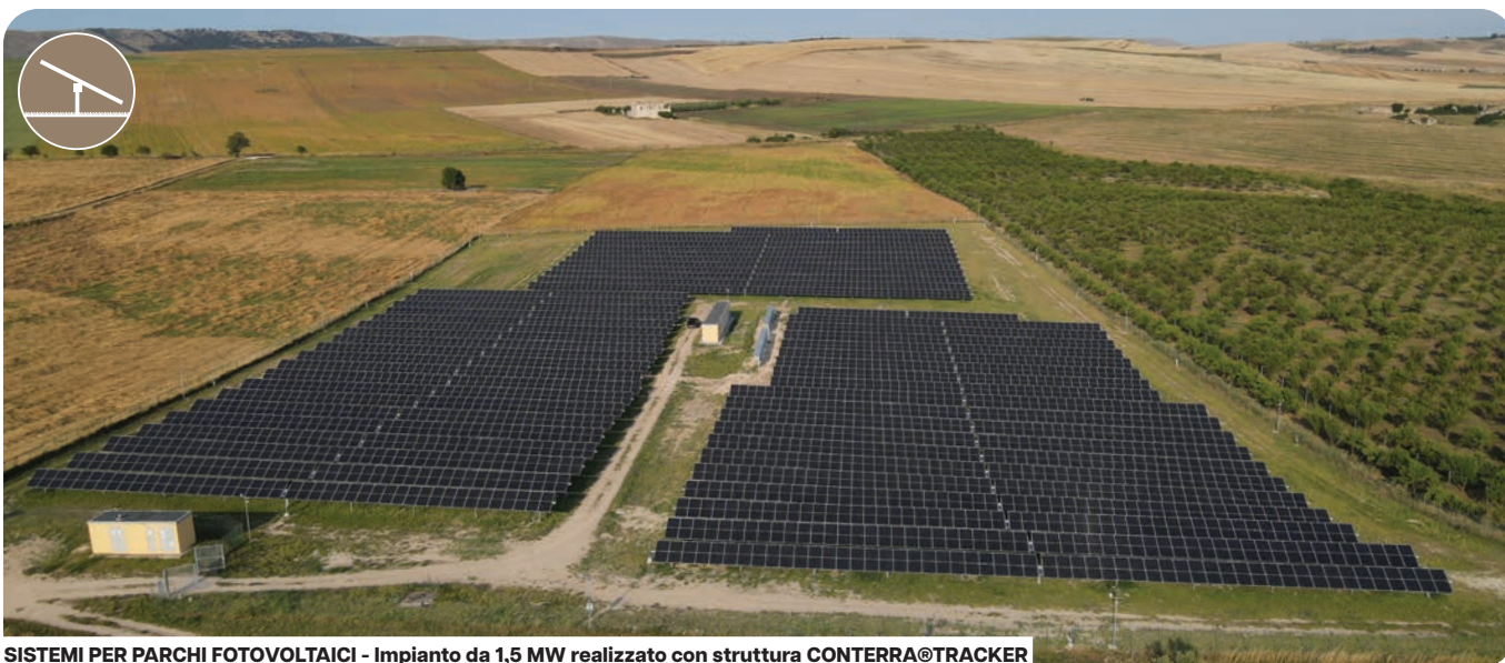
SISTEMI PER PARCHI FOTOVOLTAICI - Impianto da 1,5 MW realizzato con struttura CONTERRA®TRACKER
