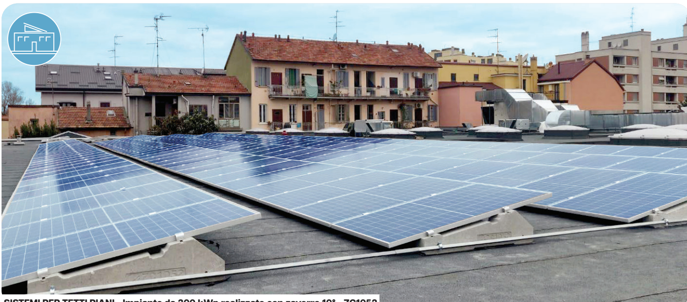
SISTEMI PER TETTI PIANI - Impianto da 300 kWp realizzato con zavorre 10° - ZC1052
