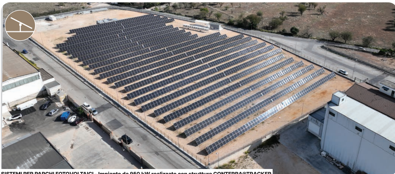
SISTEMI PER PARCHI FOTOVOLTAICI - Impianto da 950 kW realizzato con struttura CONTERRA®TRACKER
